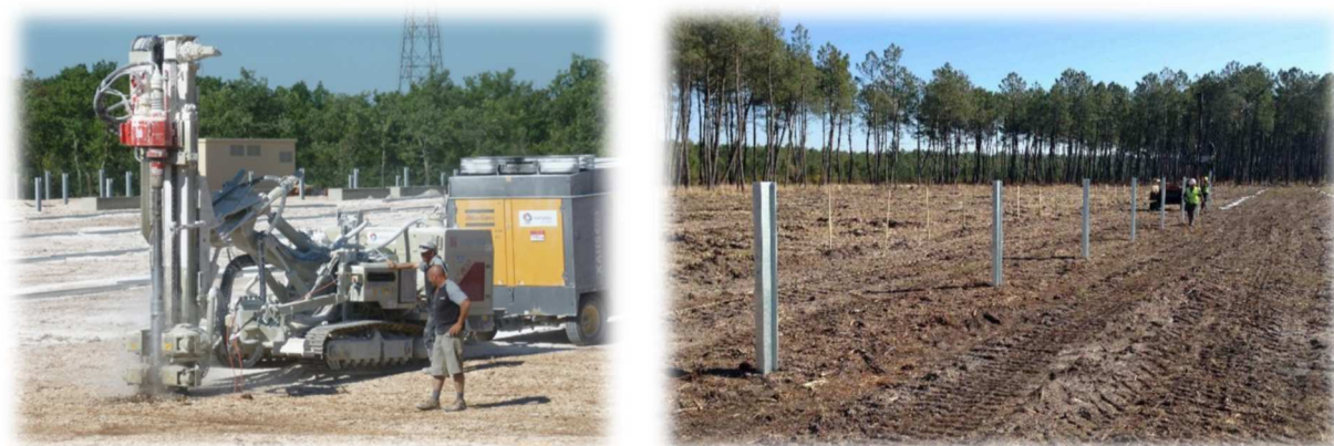
ancrage au sol par pieux battus
